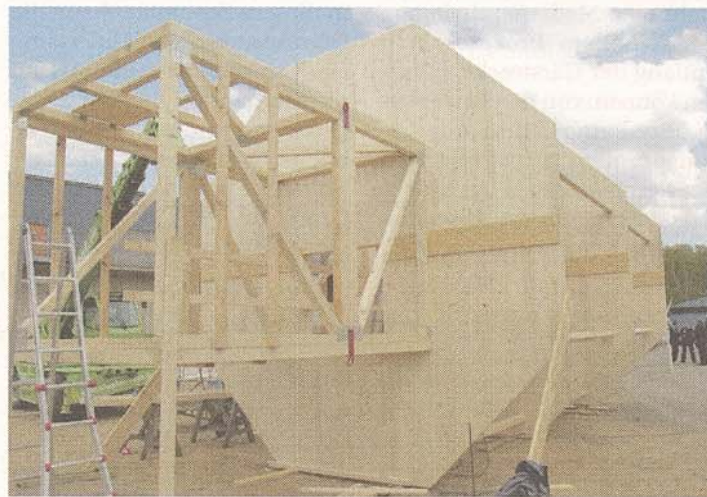
Der Holzturm für Windenergieanlagen besteht aus vielen Teilen, die sich leichter transportieren lassen.
